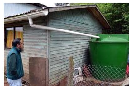
*Figura 3: Instalación de cosecha de aguas lluvias.*
