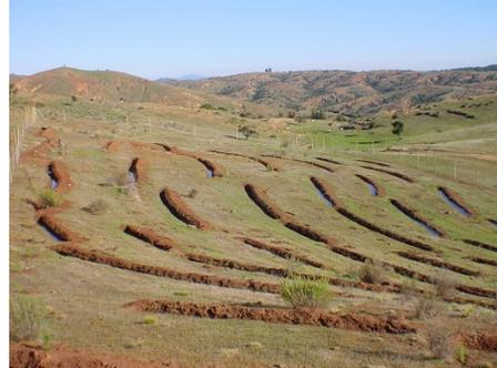
Figura 4: Zanjas de infiltración
