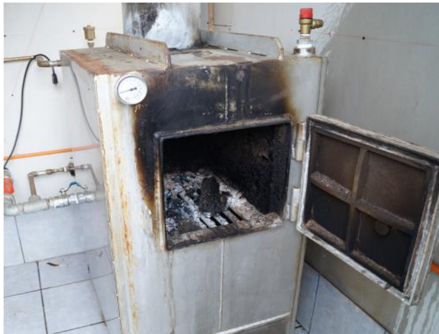
Ilustración 47: Caldera a leña con sistema de combustión
