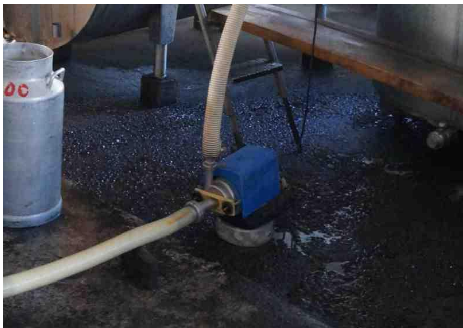
Ilustración 7: Bomba impulsora de leche a estanques fríos
