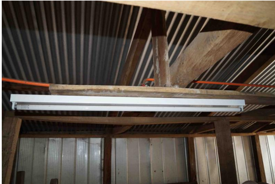
Ilustración 14: Luminarias sin protección en lugar de ordeña.
