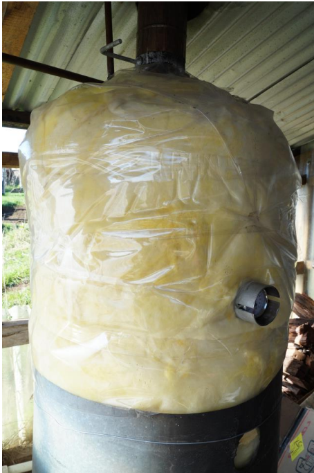
Ilustración 44: Termo tanque con mejora térmica y acumulación secundario sin aislación.
