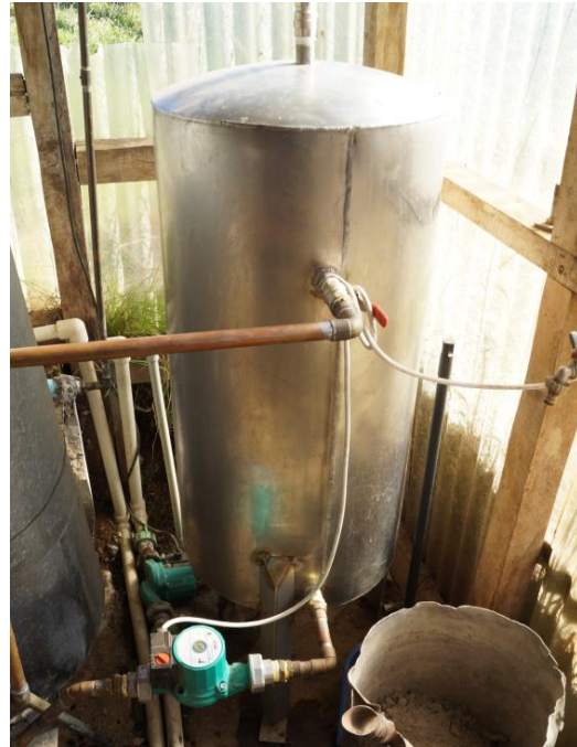
Ilustración 44: Termo tanque con mejora térmica y acumulación secundario sin aislación.
